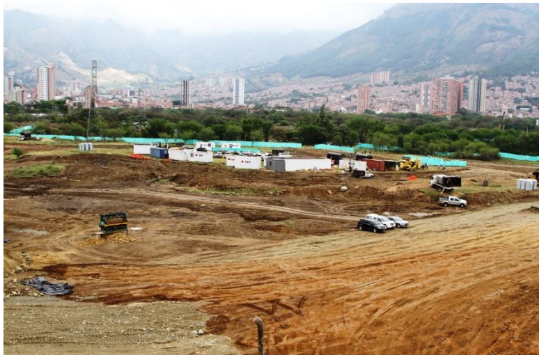
Foto. Aspectos de los trabajos en el Antioquia Central Park.
