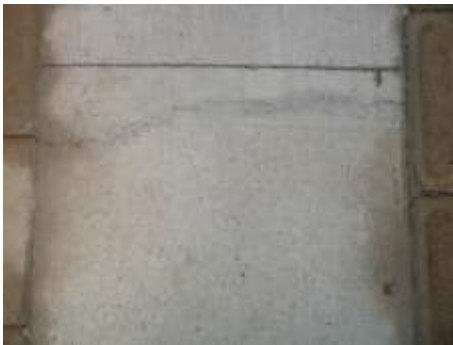
Fractura de andén en la entrada al escenario y fisuras presentadas en andenes perimetrales en el escenario de Entrerriós
