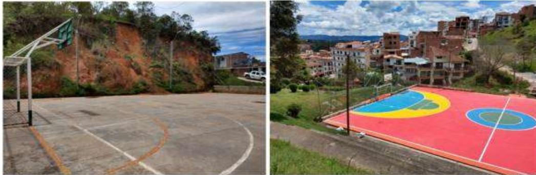
Barrio Tinajas y Barrio La Colina respectivamente. Se observa que aun no se ha iniciado con la ejecución de obra. Se debe prestar atención al talud aledaño el cual se ve afectado por las aguas lluvias .
