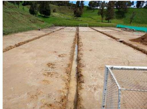
Estado actual de la cancha en obras de excavaciones y conformación de filtros de aguas lluvias.
