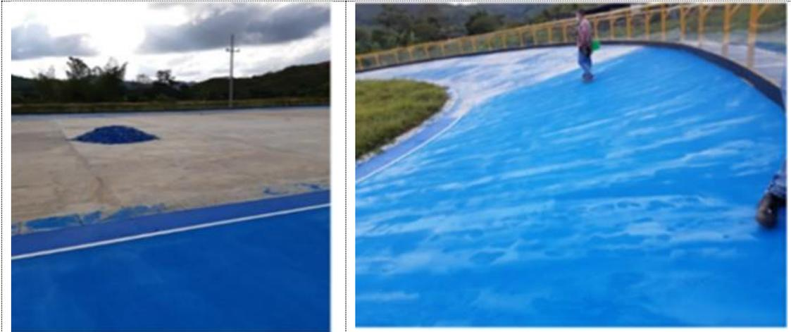
**Fuente:** Registro fotográfico captado el día 14 de mayo de 2020, se aprecia estado de la pista de patinaje, con retiro y lijado del recubrimiento instalado, debido a presencia de abombamientos de éste., presencia de puntos ferrosos en la placa de concreto
