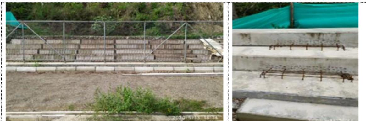
Graderías y escalones sin fundir, con acero expuesto a la intemperie.
