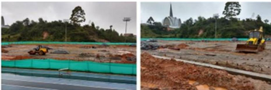
Estado actual de la cancha en obras de escavaciones y conformacion de filtros de aguas lluvias.
