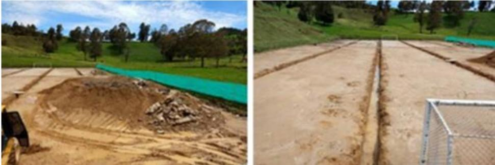
Estado actual de la cancha en obras de excavaciones y conformación de filtros de aguas lluvias.
