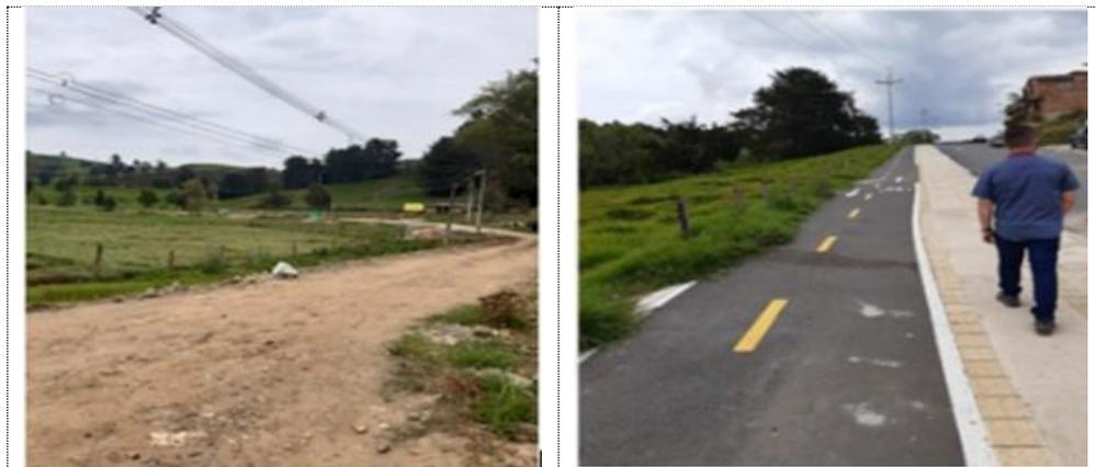
**Fuente:** Registro fotográfico captado el día 12 de mayo de 2020, izquierda: Variante a Santa Rosa (tramo suspendido), derecha: Variante Donmatías (discontinuidad en demarcación y desnivel o deformaciones en el pavimento de la ciclorruta)
