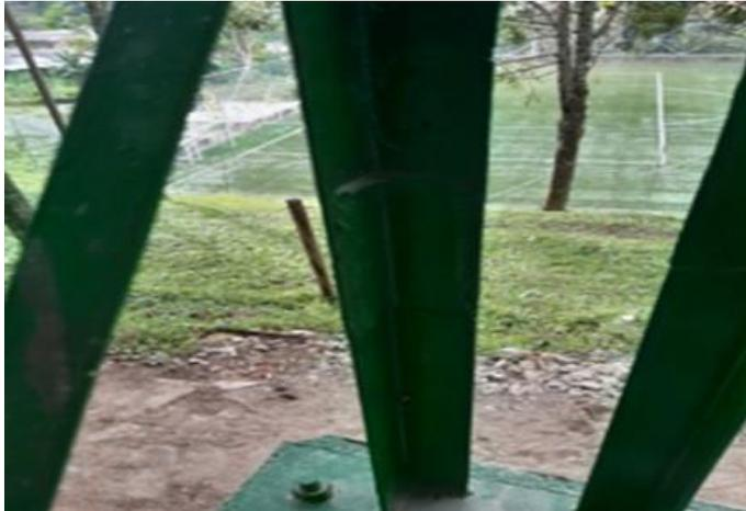
**Fuente:** Registro fotográfico captado el día 13 de mayo de 2020, detalle del empalme en columnas metálicas
