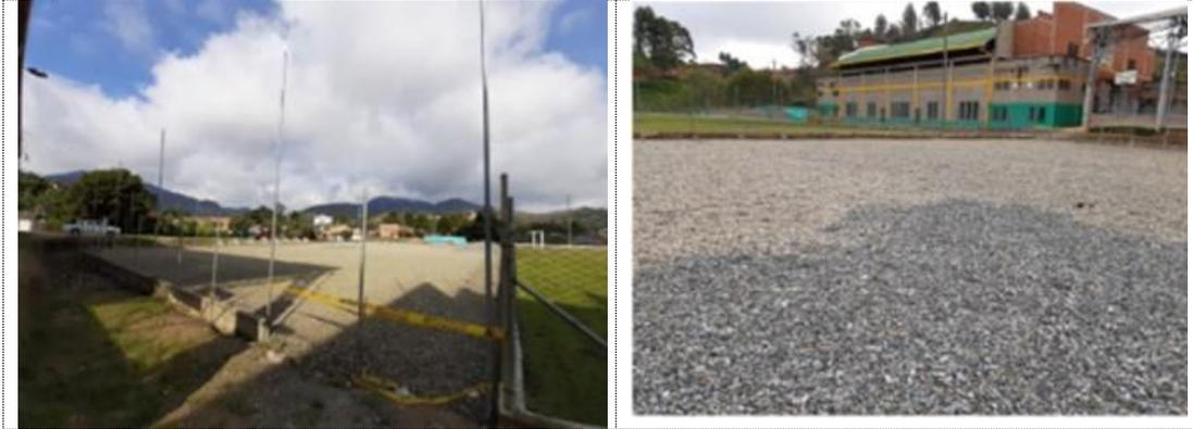
Obra con faltantes y con actividades de nivelación, inicio de cerramiento, filtros ejecutados por proveedores de VIVA, material sin cumplimiento para ser entregada por el contratista de obra a Indeportes.
