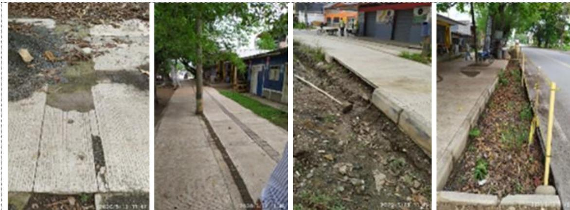
Daños en los concretos, postes eléctricos en medio de la obra, erosiones en los cordones, falta de alineamiento de la obra.
