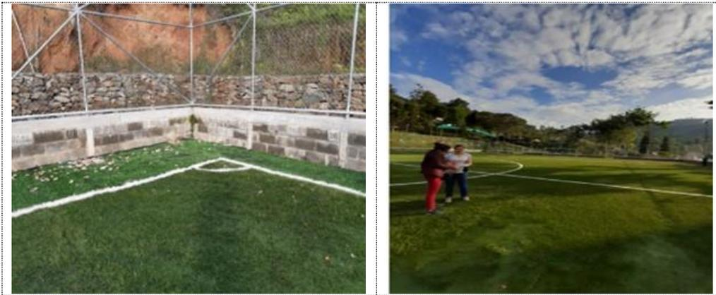
Obra terminada, pero con hallazgos por presencia de colchones de humedad, falta de material de caucho y de peinado del campo de juego.
