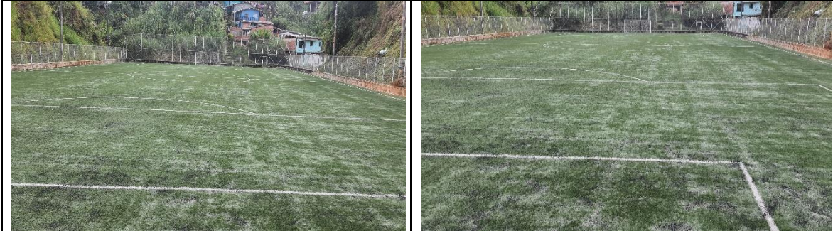
Fotos 3 y 4: parches negros donde se aprecia acumulación del caucho, parches blancos deficiencia del caucho.
