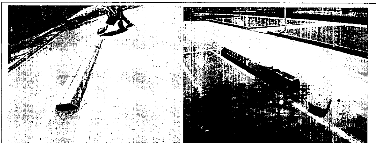
Imagen 3. Remates de segregadores
