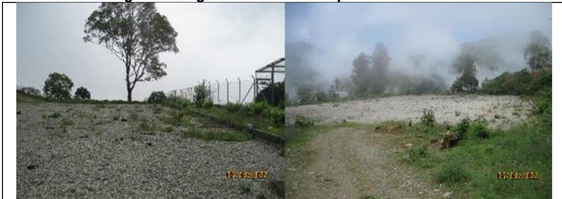
Material filtrante contaminado con hierba y excremento de animales.
