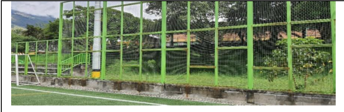
Fotos: Detrimiento prematuro de malla de cerramiento.
