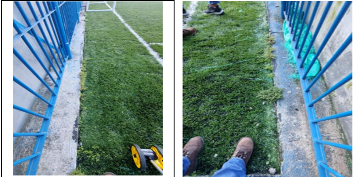
Fotos 24 y 25. Presencia de material orgánico en el césped sintético. (Sacúdete al parque, Pueblorrico)
