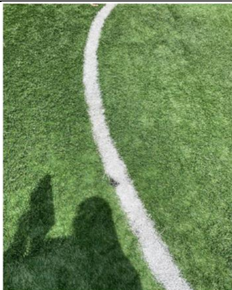
Foto 20. Líneas de demarcación de la grama, que ya se encuentran levantadas o despegadas (deficiencia en las uniones) afectando la funcionalidad, la estética y la seguridad de las instalaciones deportivas. (cancha Zuñiga en Envigado)
