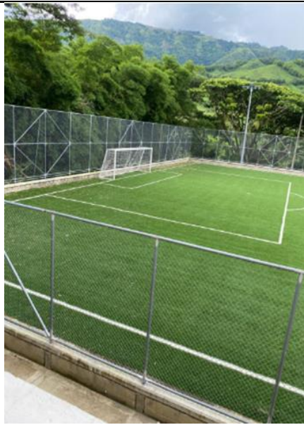
Foto 27. Área chica de 7.32m*2.9m inconsistente con las dimensiones reglamentarias según FIFA de 5.5m*18.32m, de igual manera se observaron dimensiones diferentes en el área grande que debe ser de 40.3 m*16.5m y las medidas son de 13,4m
