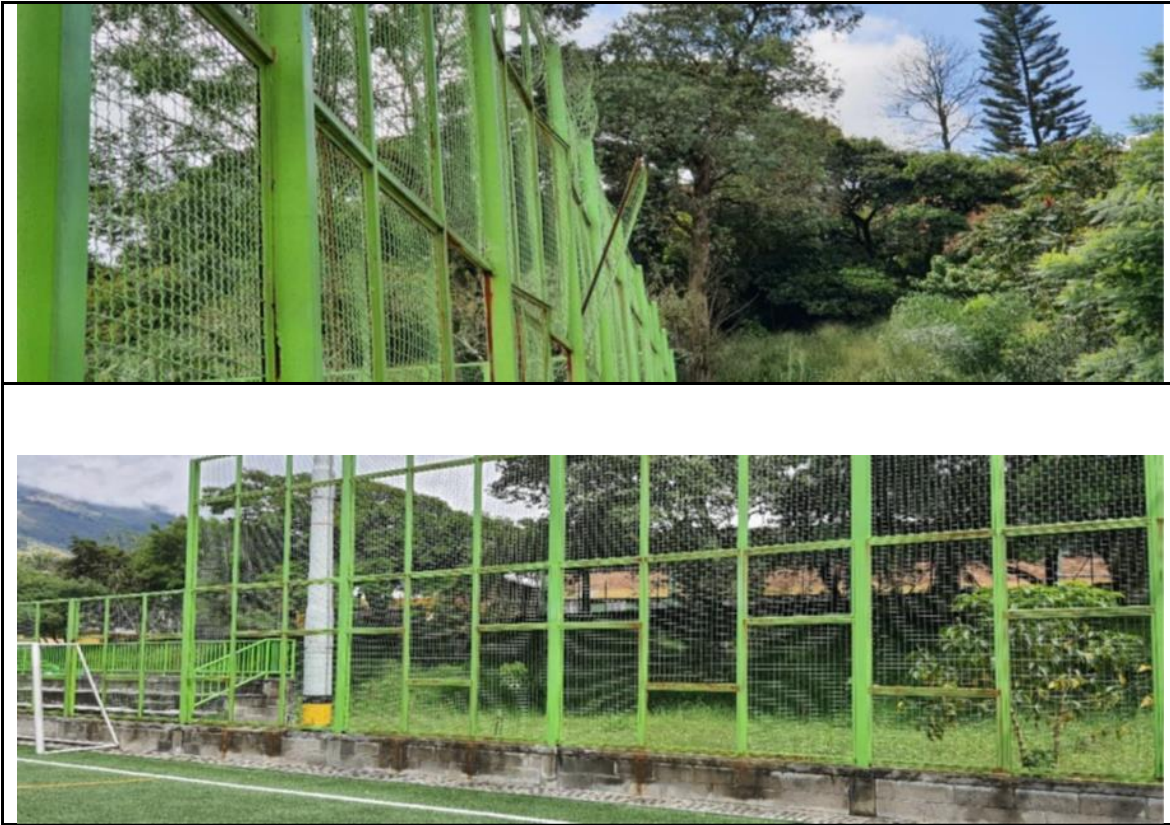
Fotos: Detrimiento prematuro de malla de cerramiento.
