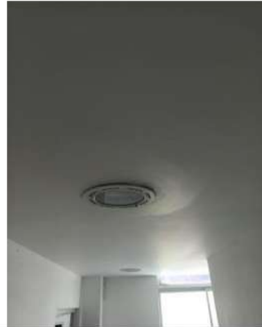
Resane en el contorno de la lampara.
